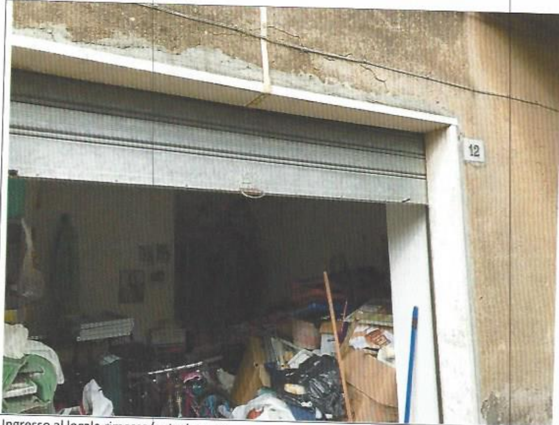
Ingresso al locale rimessa/autorimessa
